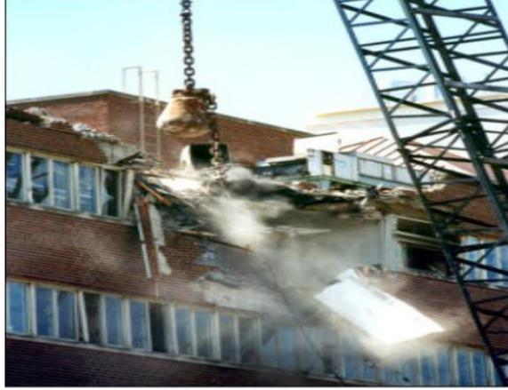
الشكل (10-1) : الهدم الميكانيكي باستخدام الكرة الساقطة.
